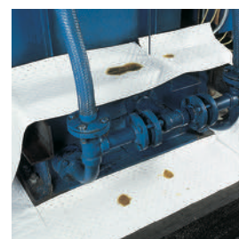
...of rond en onder machines om lekken en spatten op te vangen.
