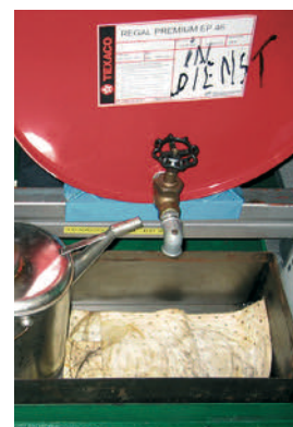
Oil Plus-doeken onder lekkende oliekannen en vaten.
